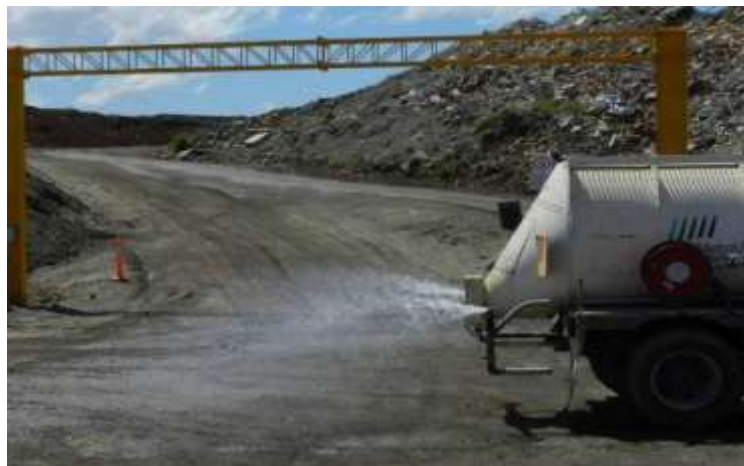
Fig 18 Slide 11 Dust suppression
